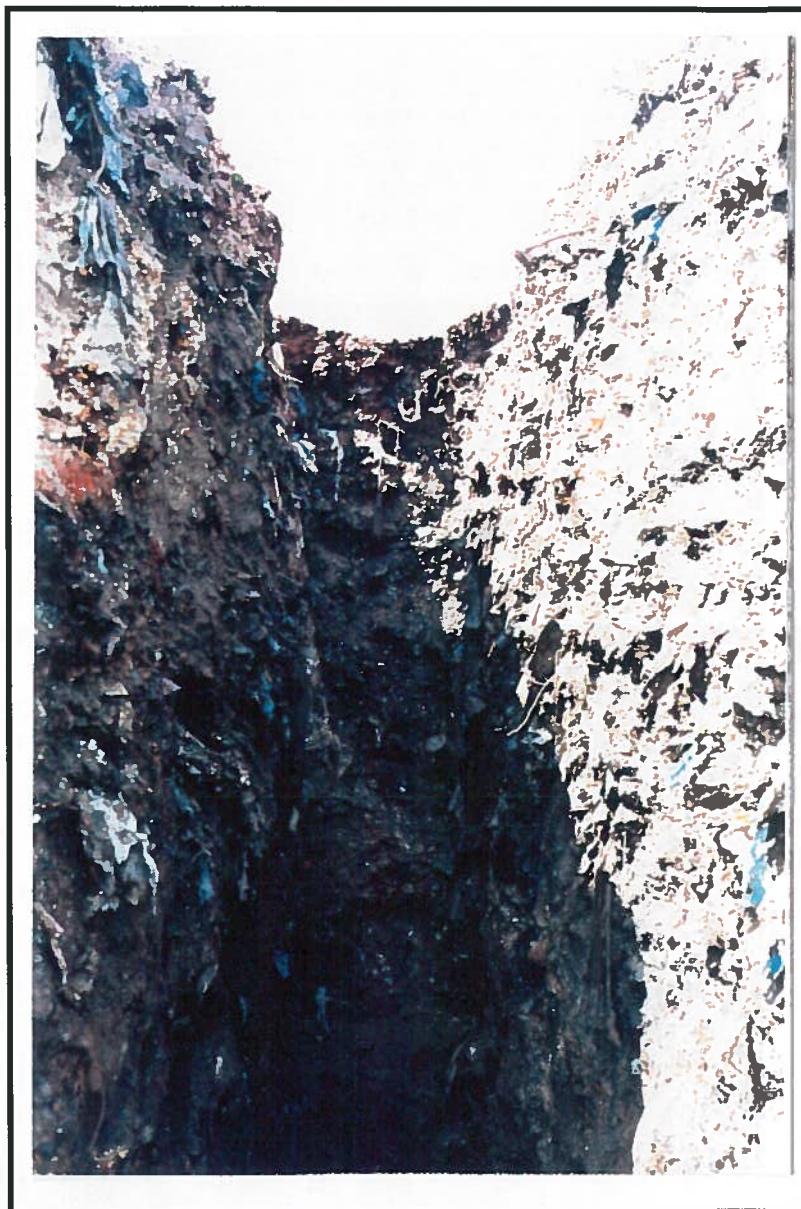
Vue de la tranchée
