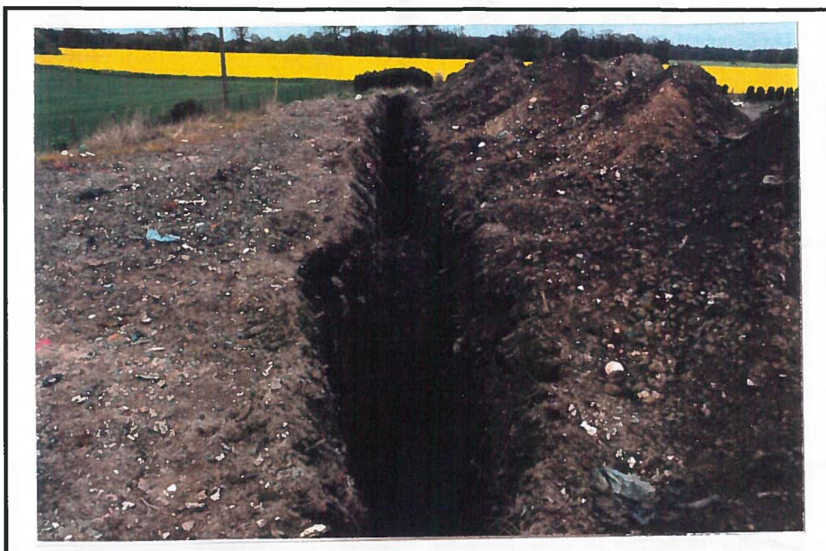
Vue de la tranchée
